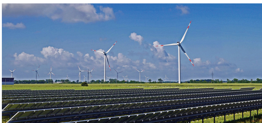
FIGURA 16 – PARQUE DE GERAÇÃO HÍBRIDA EÓLICA E FOTOVOLTAICA
