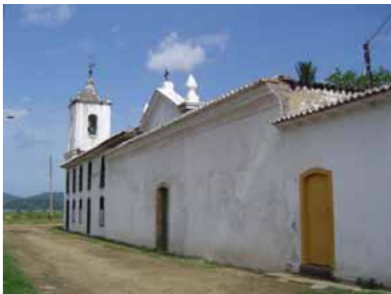
Vista da fachada lateral
