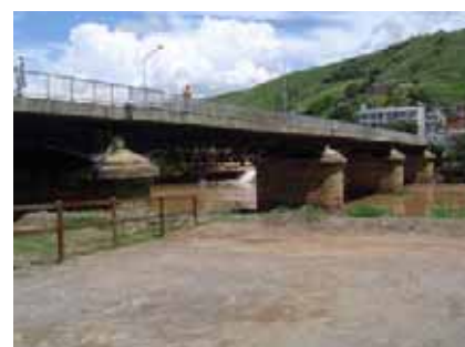
Ponte sobre o Rio Paraíba do Sul
