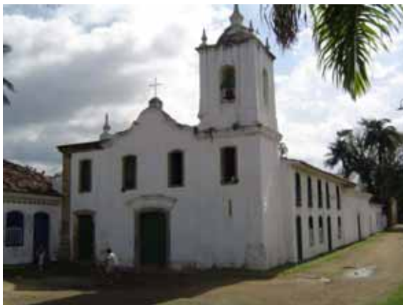
Vista das fachadas principal e lateral
