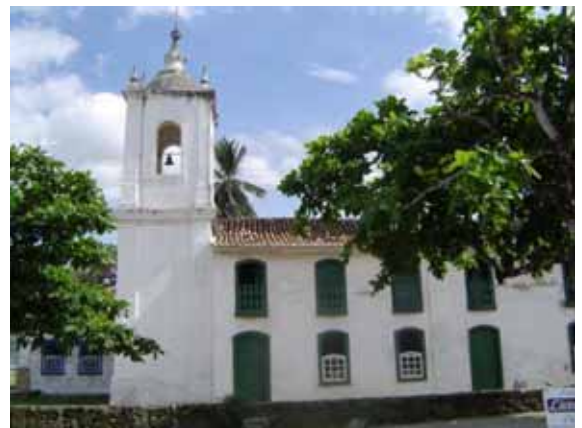
Vista da fachada lateral
