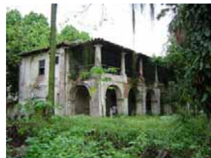
Fachada lateral da Casa e Capela da Fazenda São Bento
