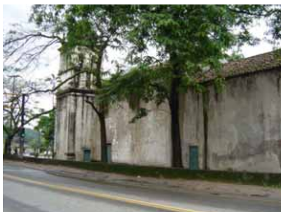
Fachada lateral correspondente à vista 2
