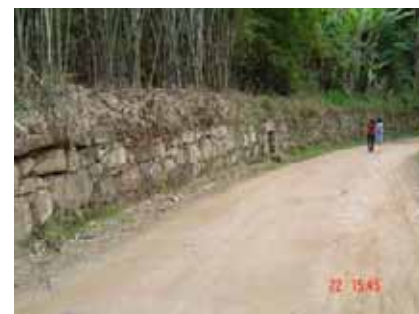
Muro de arrimo entre Secretário e Inconfidência
