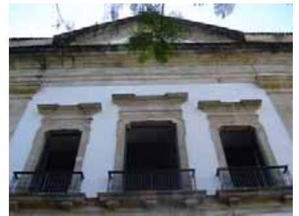
Aspecto da fachada da Igreja Matriz de N.S. dos Remédios de Paraty
