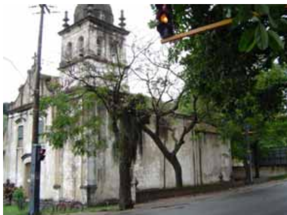
Fachadas correspondentes às vistas 1 e 2
