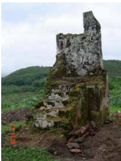
Escada de acesso à torre sineira
