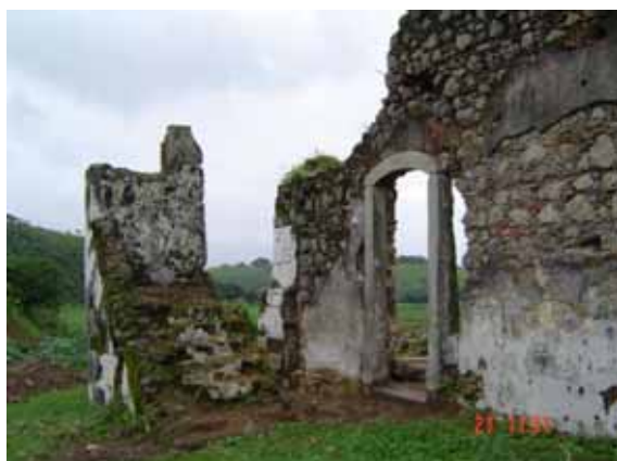
Escada remanescente - entrada lateral para a nave
