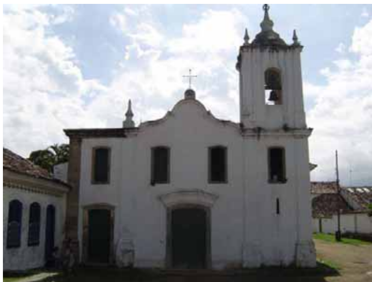
Fachada principal da Igreja de N.S. das Dores
