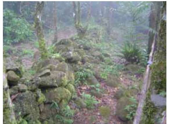
Vista dos alicerces do muro
