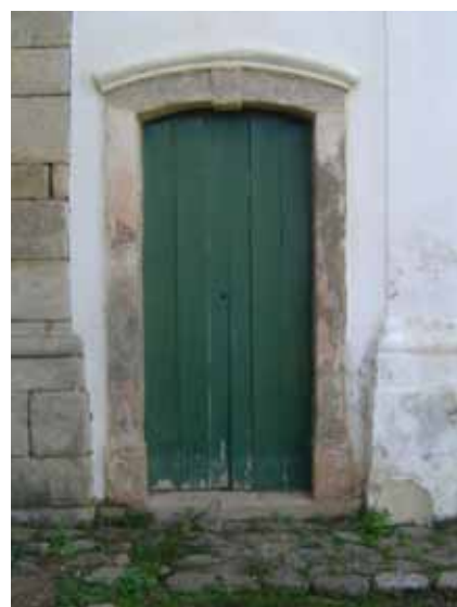
Detalhe da esquadria
