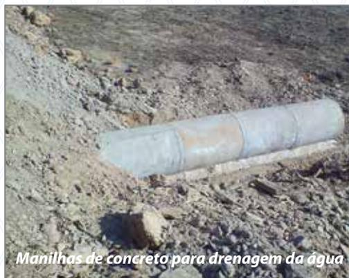
*Manilhas de concreto para drenagem da água*
